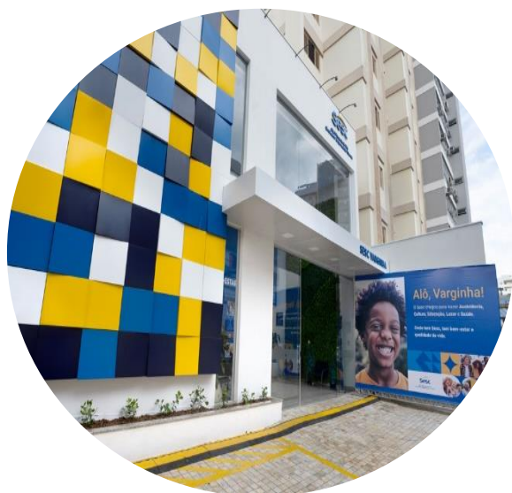
Foto: Fachada da Nova Unidade – Sesc Varginha
